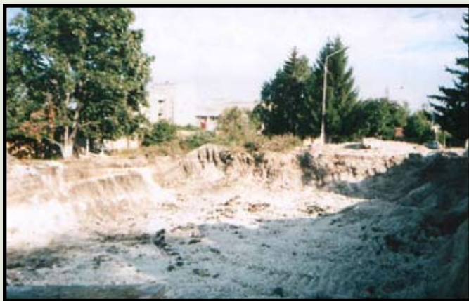
Котлован нового собора. Лето 2004.
