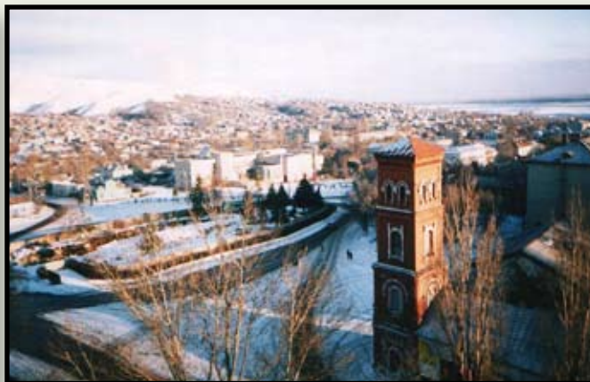
Стройплощадка собора. Декабрь 2004.
