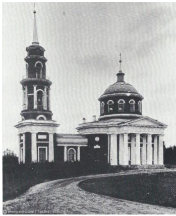
Церковь Иконы Божией Матери Ахтырская.
