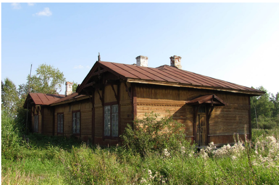
Станция Колчедан, сохранившееся дореволюционное здание, 2017 г.
